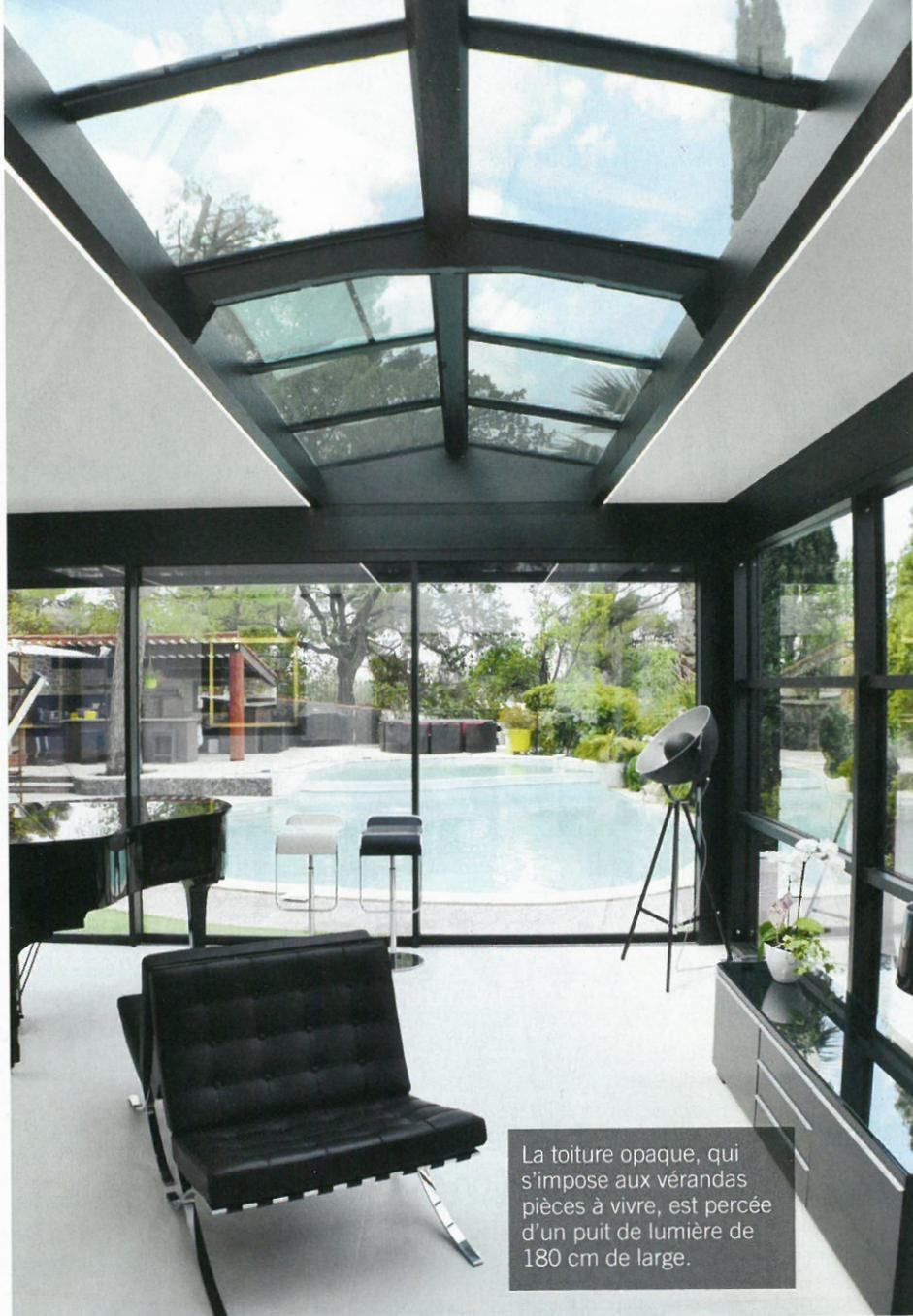
La toiture opaque, qui s'impose aux vérandas pièces à vivre, est percée d'un puit de lumière de 180 cm de large.
